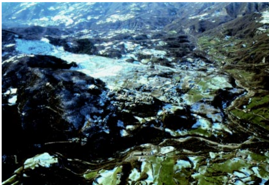
Figura 7. Veduta panoramica della frana di Corniglio (27.11.1996). Si possono notare le grandi dimensioni dell'area dissestata e le trincee nel crinale retrostante il paese.
