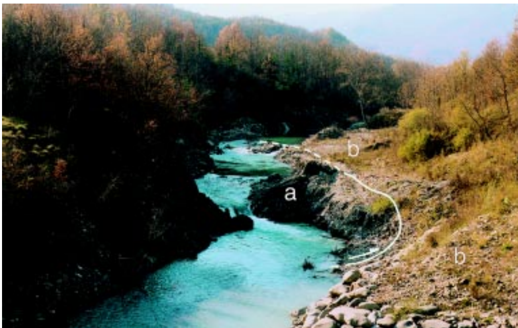
Figura 11. Alveo del T. Parma (Novembre 1996), con emersione dell'unghia di frana (a), determinante una progressiva diminuzione della sezione di deflusso ed il sollevamento delle alluvioni fluviali (ghiaie: b).
