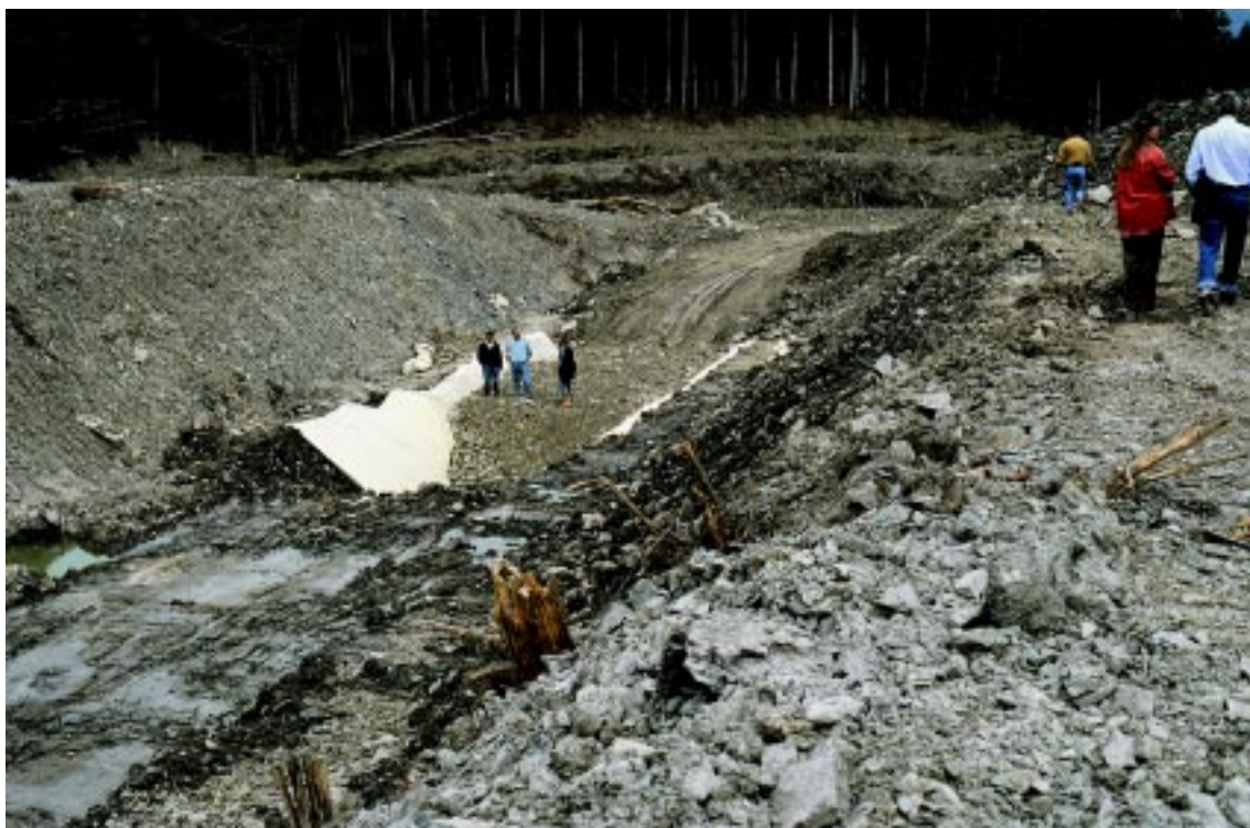
Figura 24. Trincea drenante realizzata nell'estate 1995, per il consolidamento del corpo di frana caratterizzato da colate superficiali. In molte trincee furono utilizzati, come materiale drenante, tronchi, ravvolti in geotessile, provenienti dalla pineta distrutta dalla prima riattivazione e non riutilizzabili diversamente (cfr. fig. 30).
