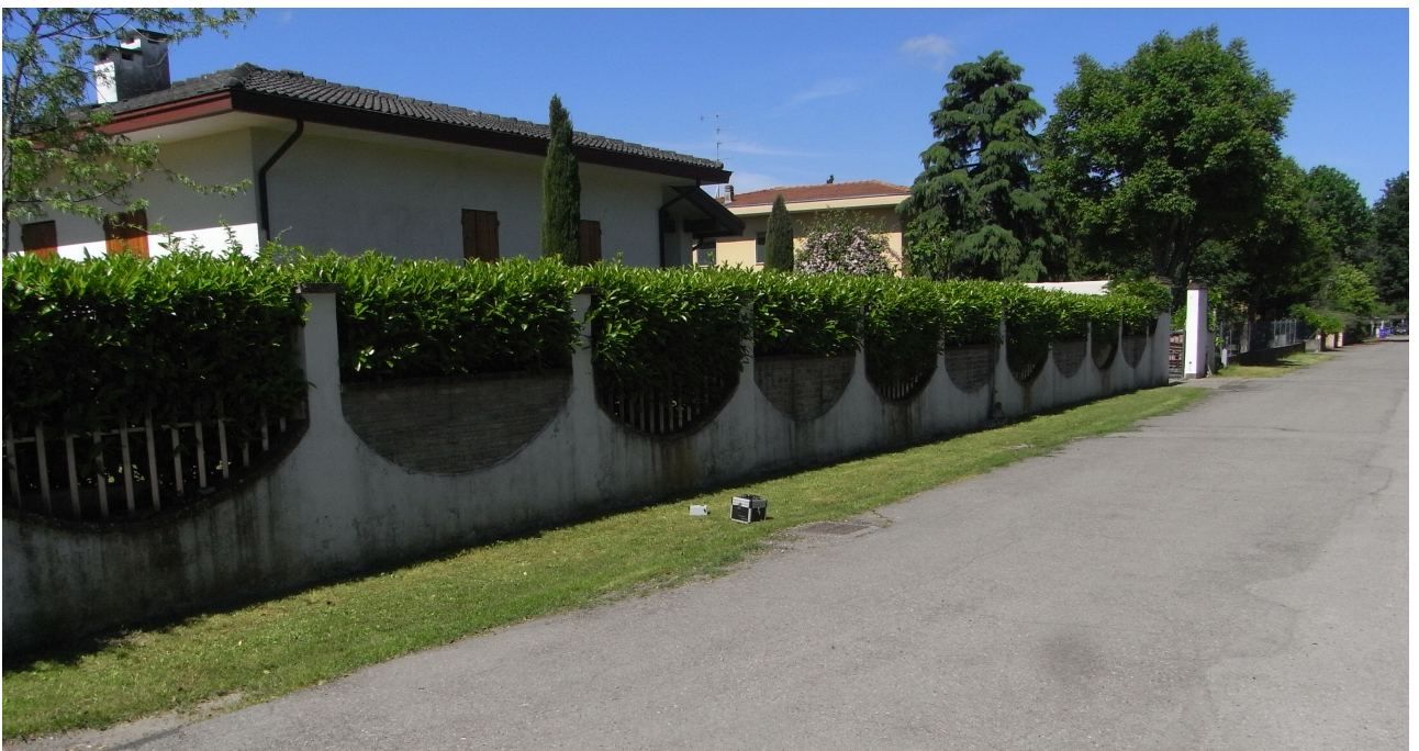
Fig. 4.5 – Esecuzione indagine MZS 6 (ID_INDPU: 034019P146HVSR181).
