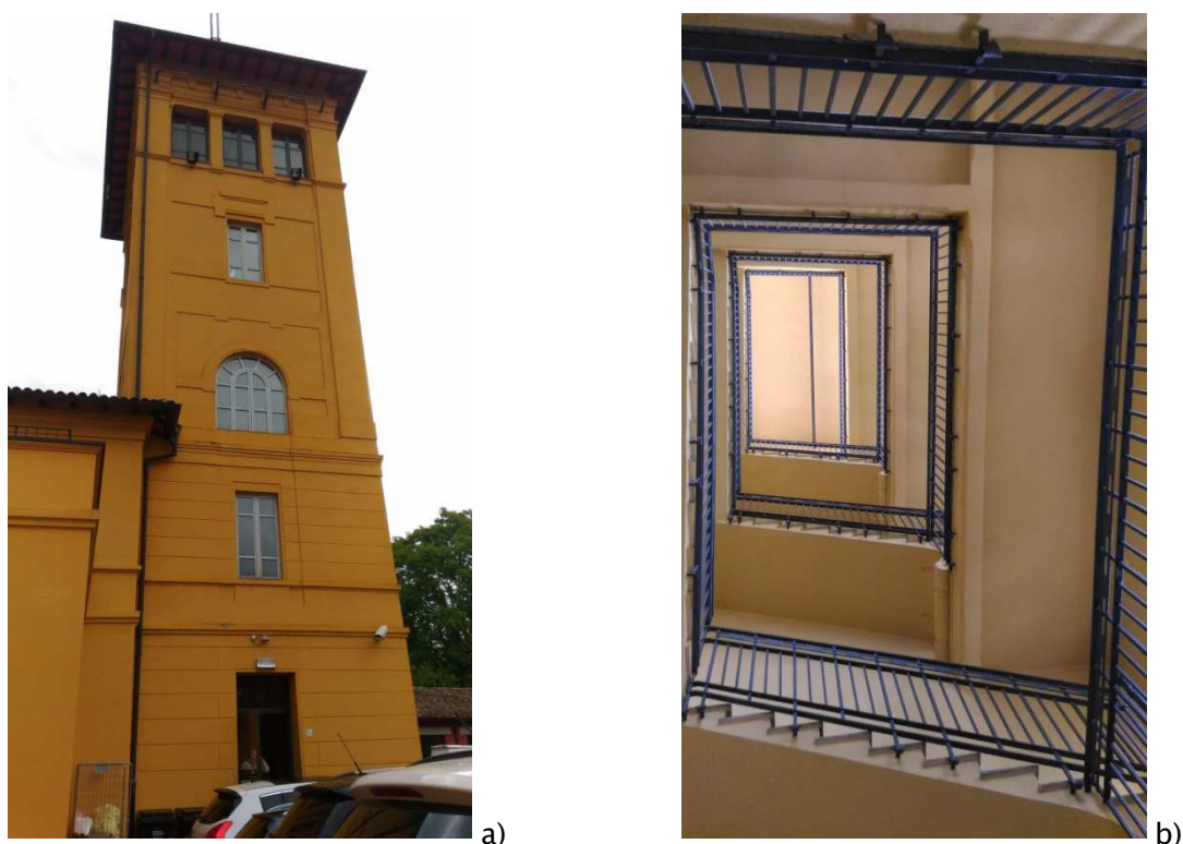
Fig. 4.15 – Vista esterna a) e interna b) della torre della sede dell’Assistenza Pubblica – Parma.
