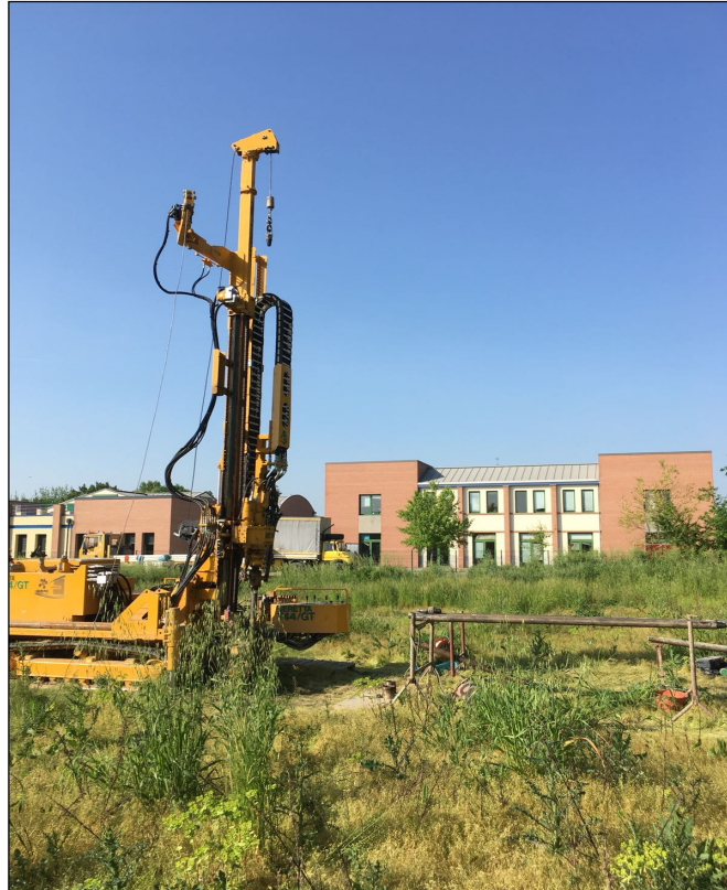
Ubicazione sondaggio S2
