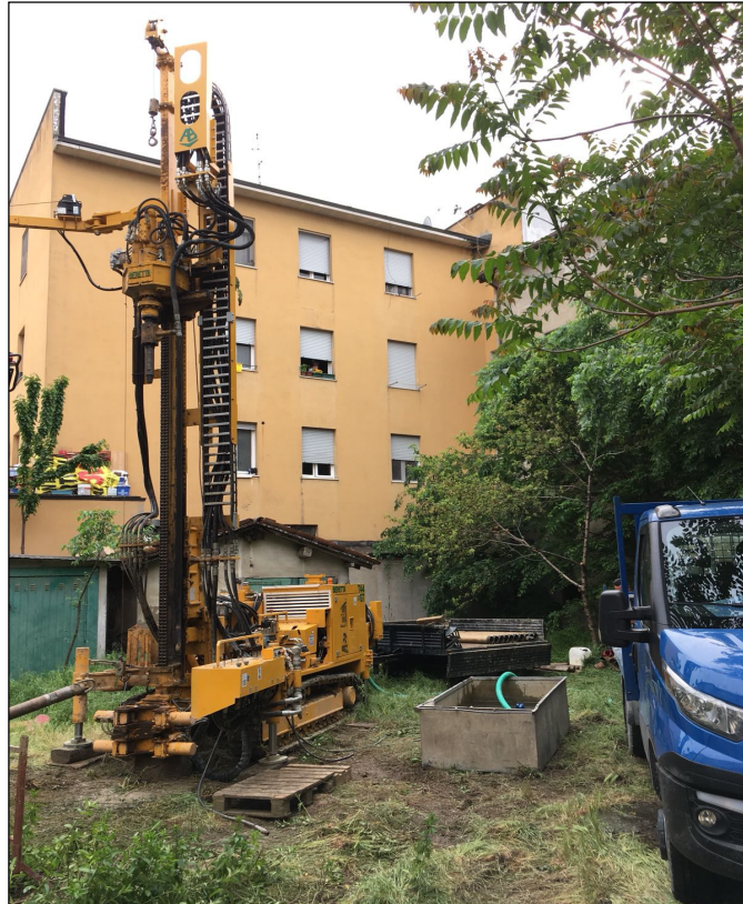
Ubicazione sondaggio S1
