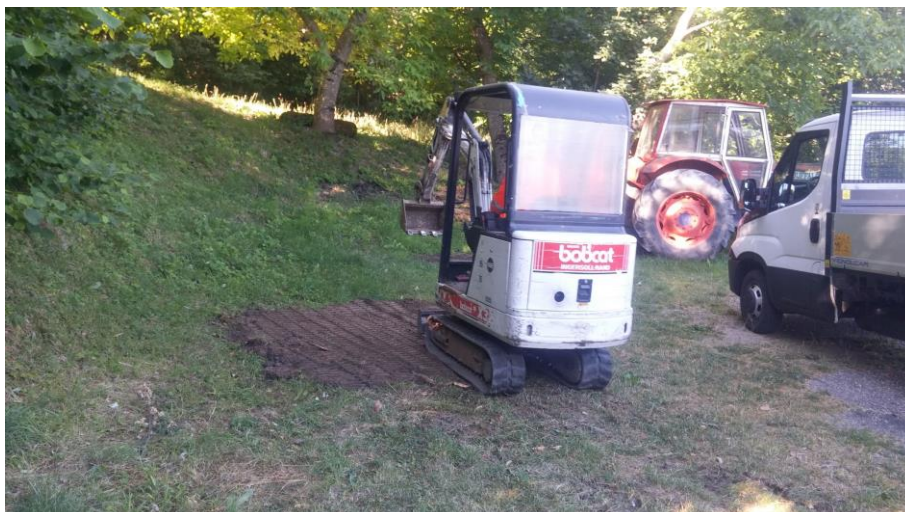
Realizzazione della trincea di scavo per il prelievo del campione F2
