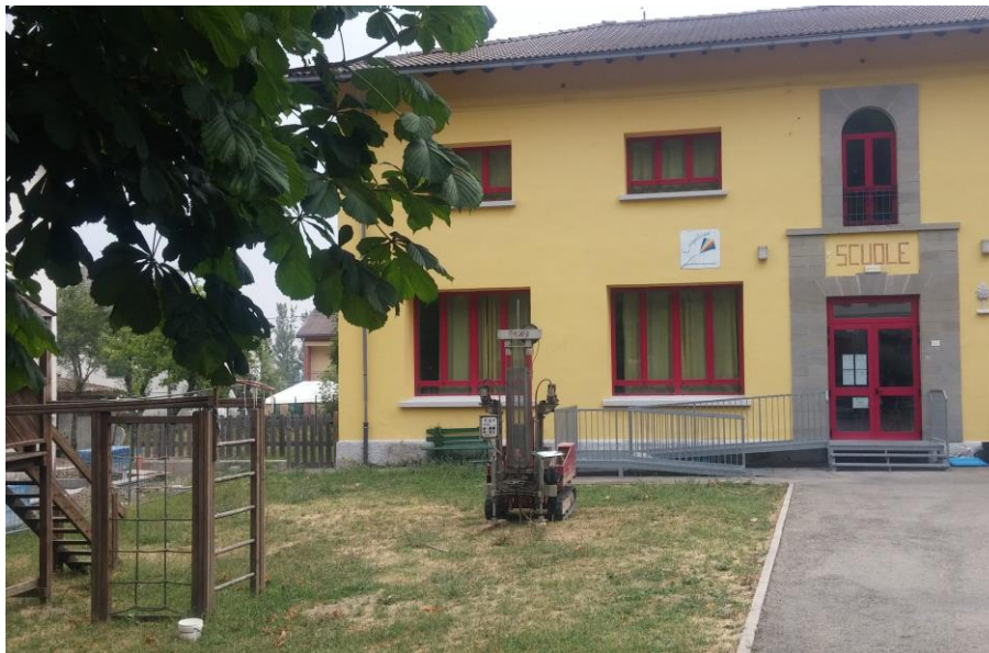
Realizzazione della prova penetrometrica dinamica DPSH 036016P115DS115
