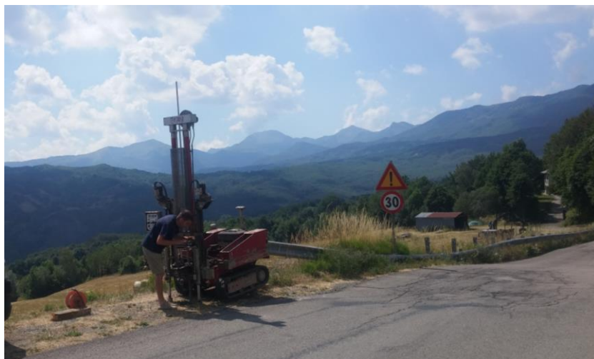
Realizzazione della prova penetrometrica dinamica DPSH 036016P112DS112
