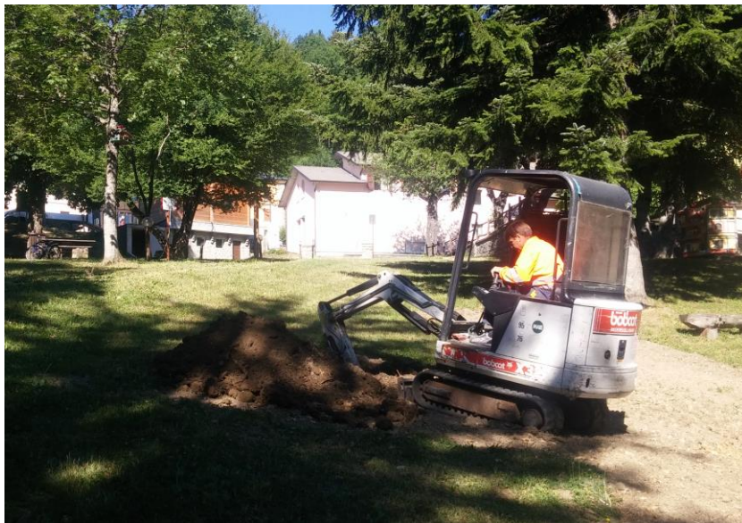
Realizzazione della trincea di scavo per il prelievo del campione P1
