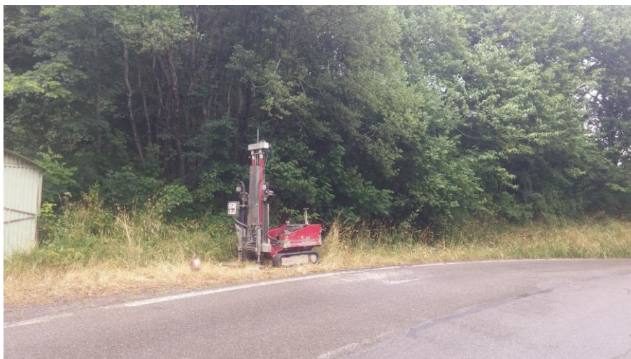
Realizzazione della prova penetrometrica dinamica DPSH 036016P116DS116
