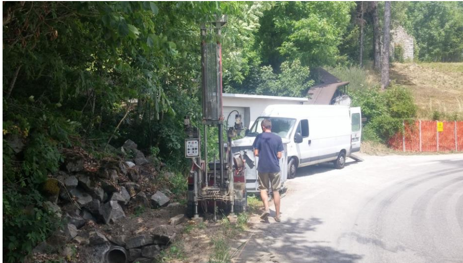
Realizzazione della prova penetrometrica dinamica DPSH 036016P113DS113
