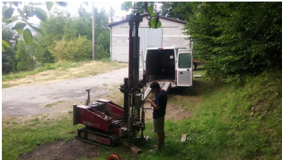
Realizzazione della prova penetrometrica dinamica DPH 036016P114DS114
