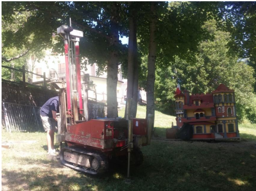
Realizzazione della prova penetrometrica dinamica DPSH 036016P111DS111
