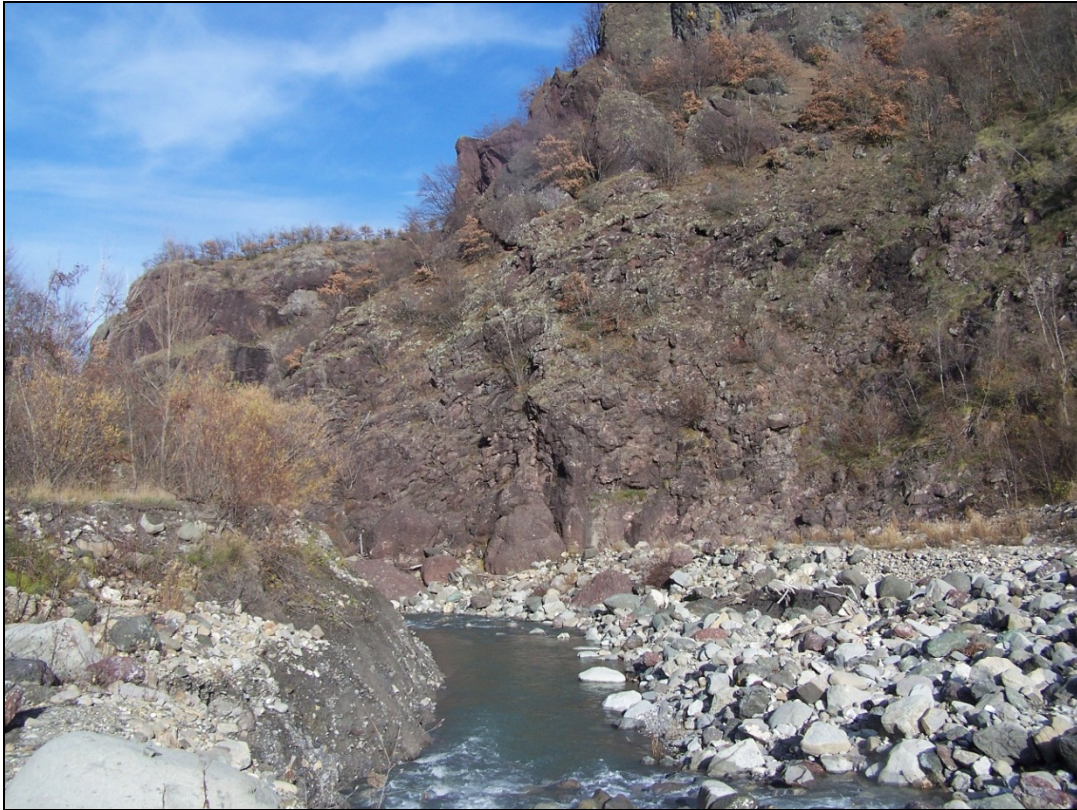
Figura 30 – Basalti rossi alla base della massa ofiolitica del Poggio Bianco Dragone (fianco destro del Dragone, Comune di Palagano). Sulla sinistra, depositi riferibili alla zona di piede della frana di Tolara che, in passato, hanno determinato, probabilmente più volte, l'ostruzione del corso d'acqua e la formazione di un bacino lacustre effimero.
