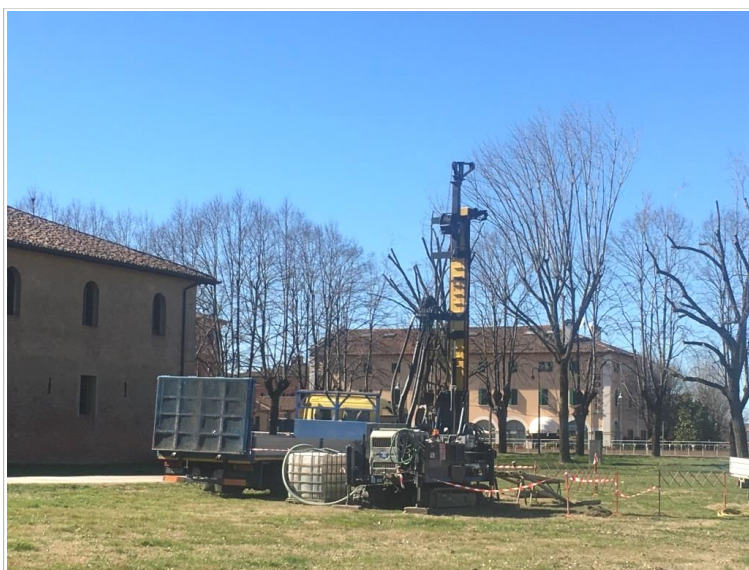
Foto 4.1 - Esecuzione del sondaggio a Bentivoglio
