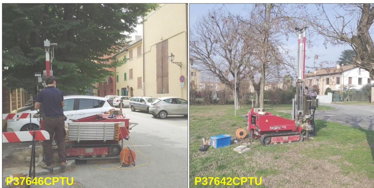
Foto 4.1 - Prove CPTU eseguite nel Capoluogo – centro storico – (a sx) e presso la frazione Mezzolara (a dx)
