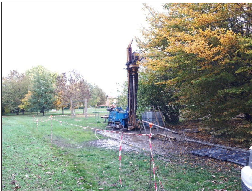
Foto 4.1 - Esecuzione del sondaggio nel Capoluogo (area verde via della Costituzione)
