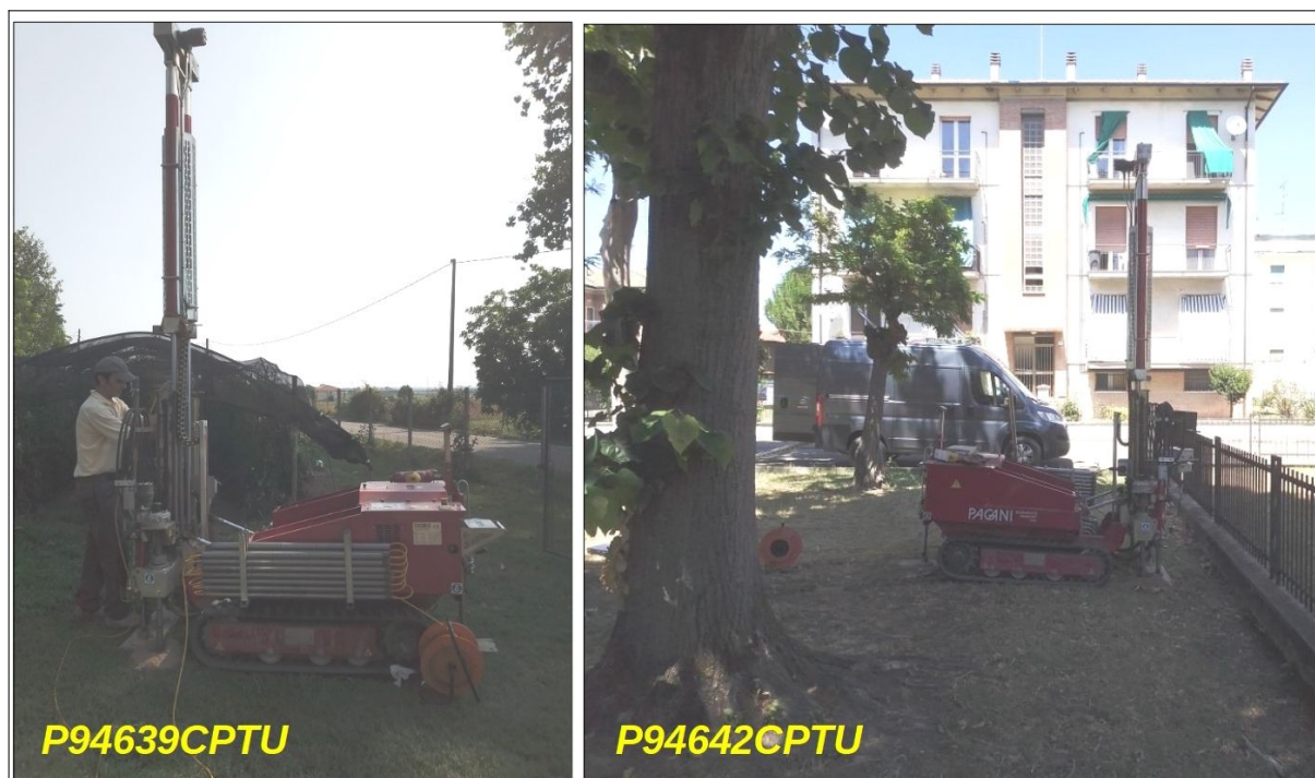
Foto 4.3 – Prove CPTU eseguite a Capo d’Argine (P94639) e nel Capoluogo (P94642)
