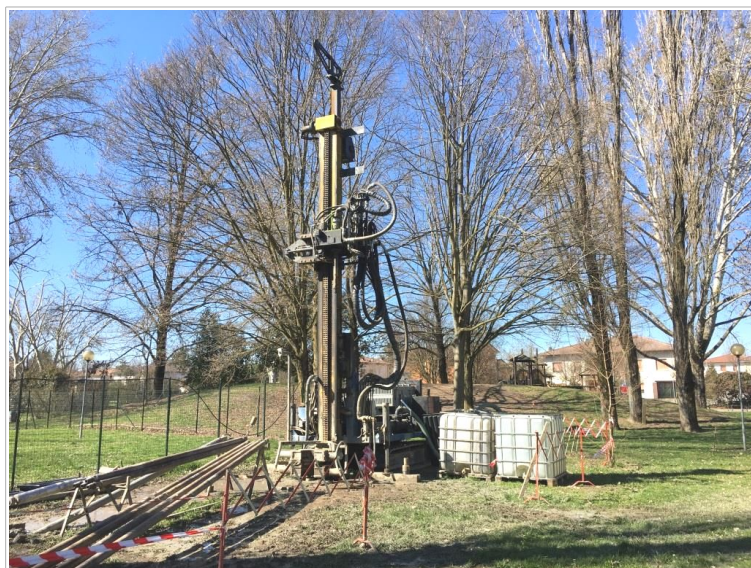
Foto 4.1 – Esecuzione del sondaggio a Pieve di Cento
