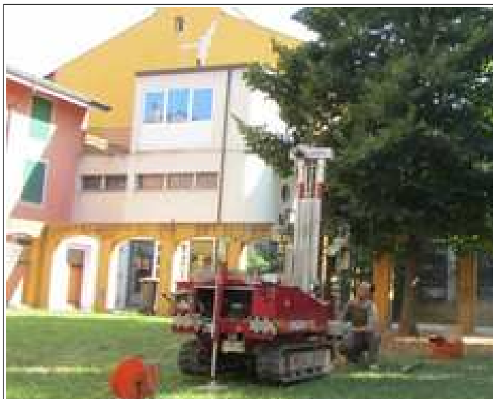
Foto 4.1 - Una delle prove CPTU eseguite nel Capoluogo (zona "centro storico")
