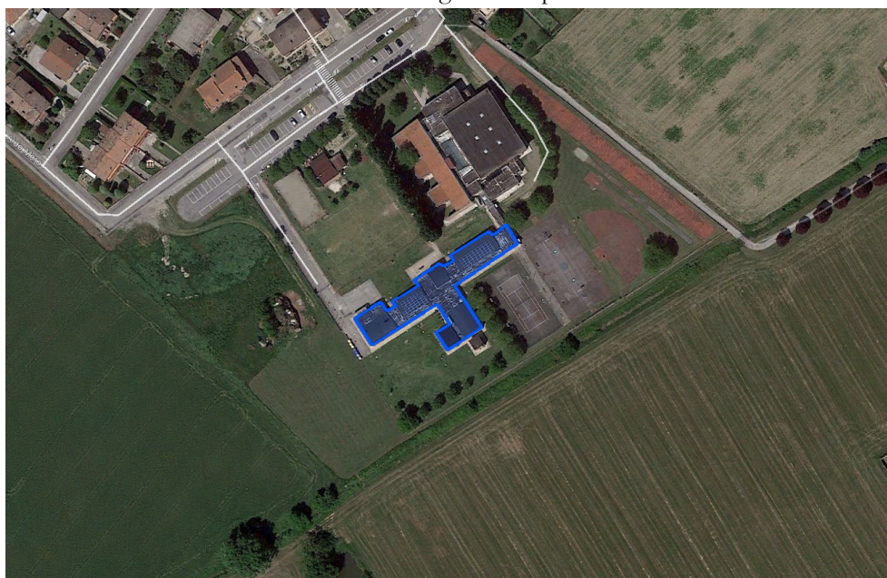
Strutture Esistenti - EDIFICIO STRATEGICO – SCUOLA ELEMENTARE VIA G. DA CARPI, 11 Area di accoglienza coperta
