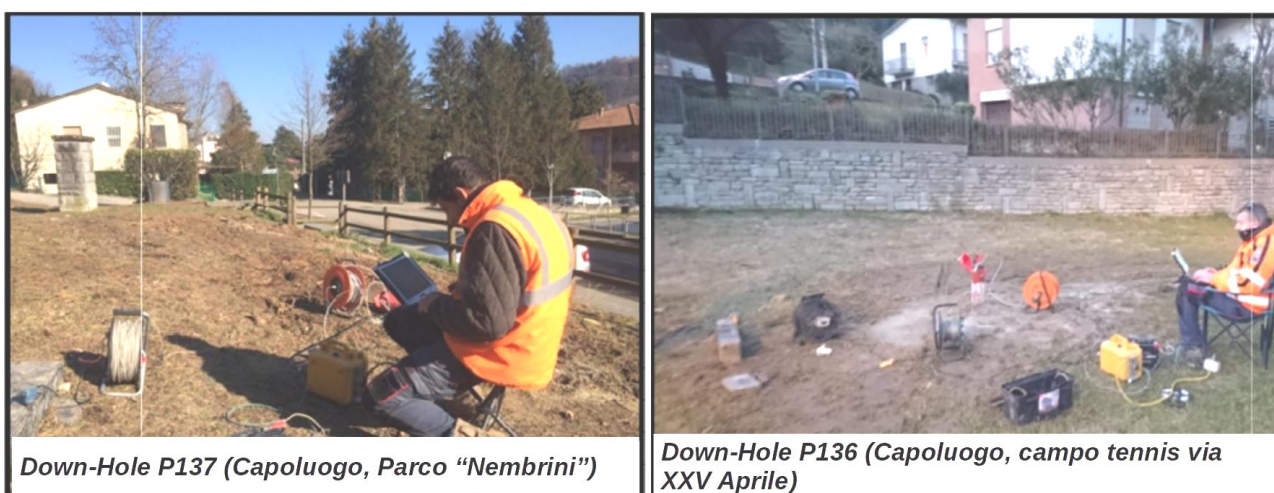
Foto 4.2 – Esecuzione delle due prove sismiche in foro “Down-Hole” nel Capoluogo.
