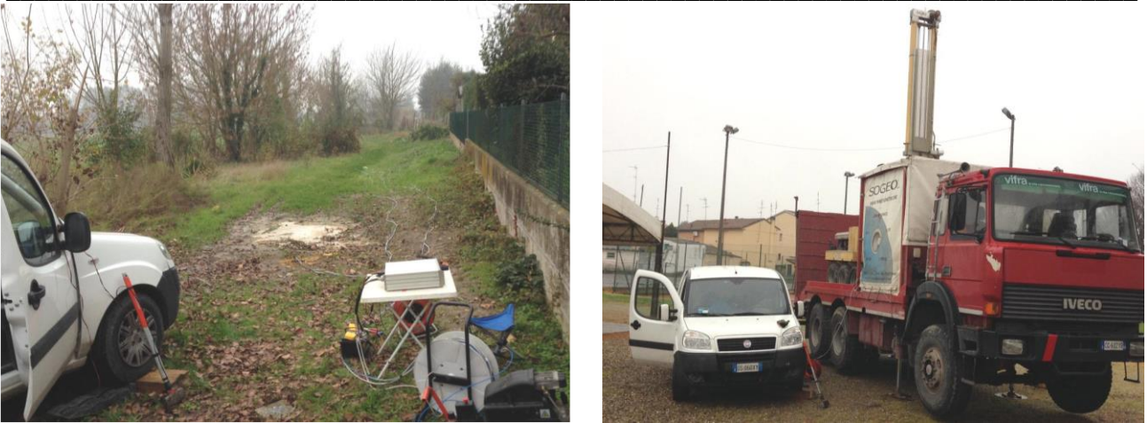
Figura 5.4– Nel pannello di sinistra, indagine Down-Hole. Nel pannello di destra, indagine con Cono Sismico.
