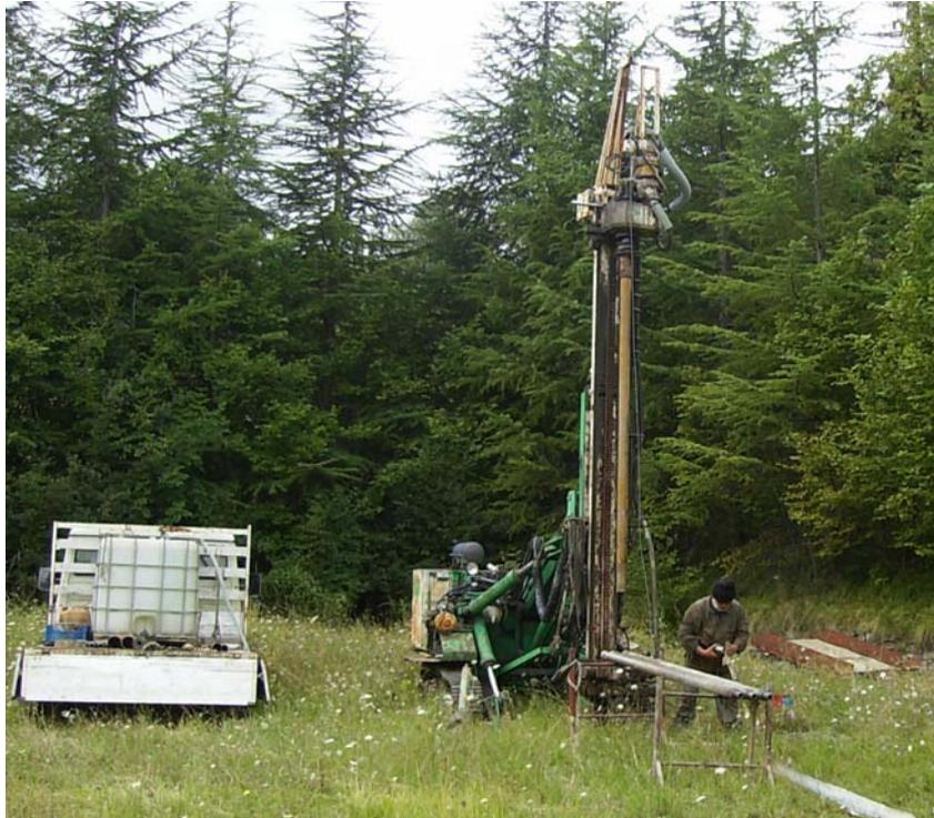
**Figura 2:** Sonda posizionata per il sondaggio geognostico in Loc. Vialta
