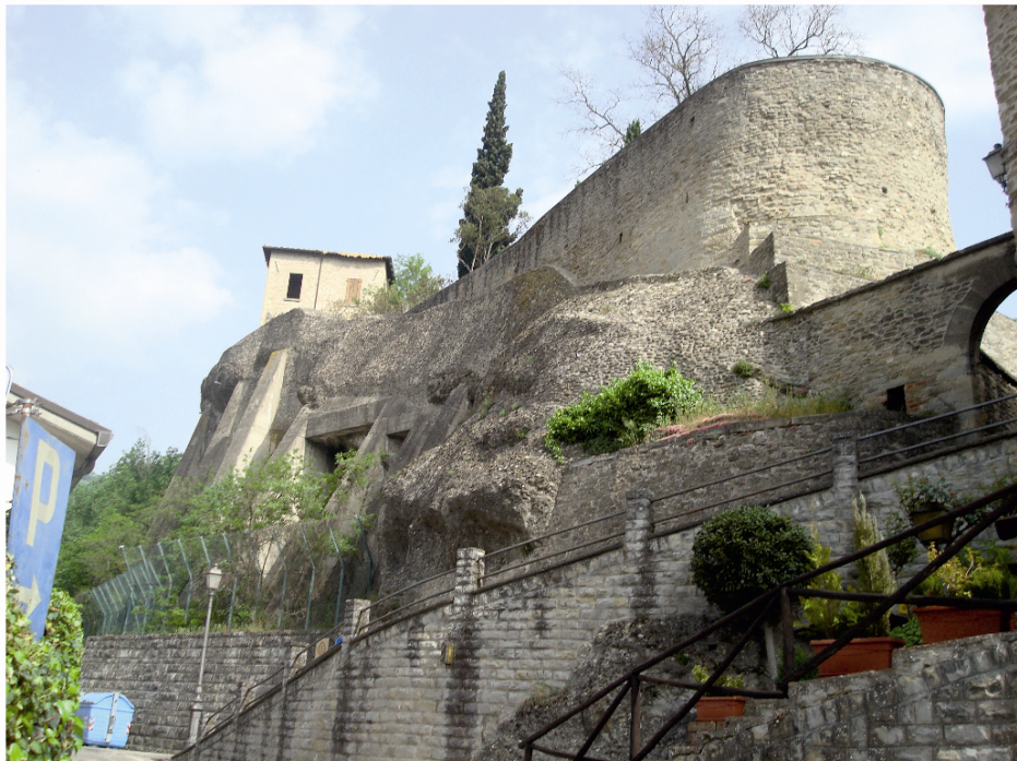
Foto 2 - particolare delle opere di sostegno lungo il margine ovest della scarpata che contorna la rocca di Cusercoli
