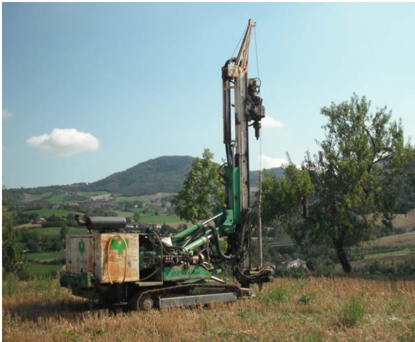
Figura 23: Sonda posizionata per l'esecuzione del sondaggio geognostico
